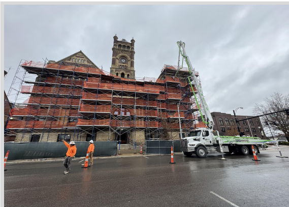
Attic SOMD Concrete Pour 12/13/24
