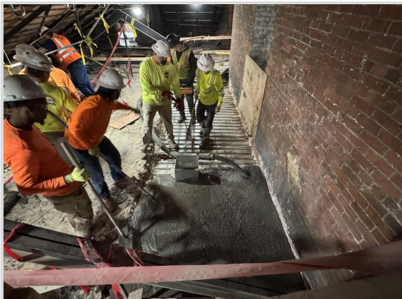
Attic SOMD Concrete Pour 12/13/24
