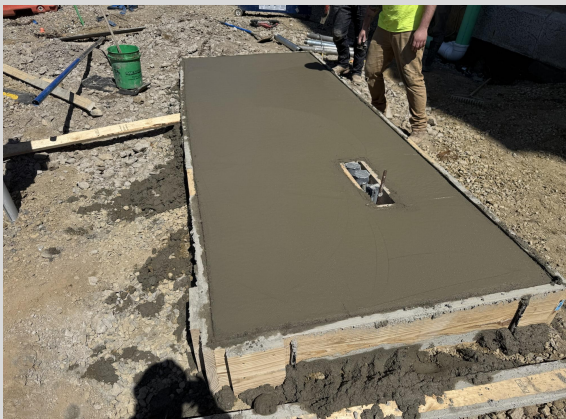
Generator Pad Pour 4/25/25
