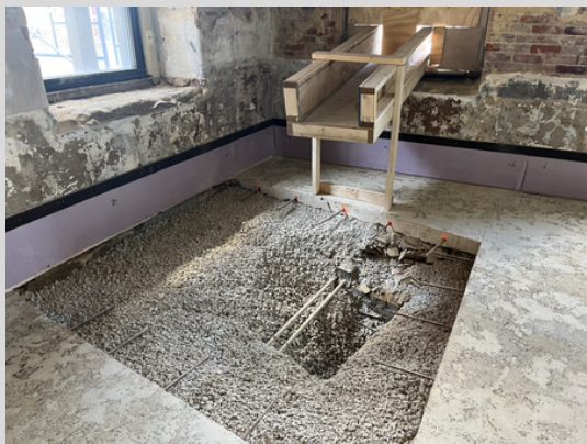
Underground Tunnel Pour Prep 6/28/24
