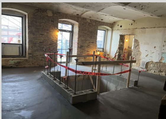
Elevator Room Slab Pour 7/25/24
