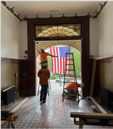
Exterior Door Frame Install 7/11/25
